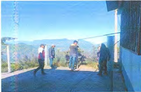
Foto 1: Sustitucion de maya y acabado de circulación y puerta de 1m 20cm
