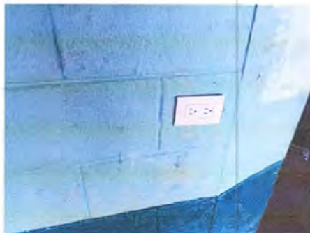
Foto7: instalación de luz electrica, tomacorrientes y apagadores
