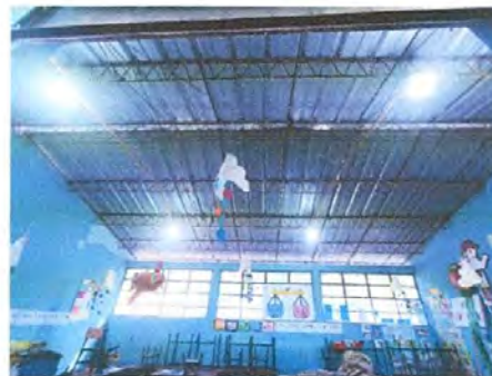
Foto 8: flaponeras y cambio de focos grandes ahorradores para 3 aulas y corredor
