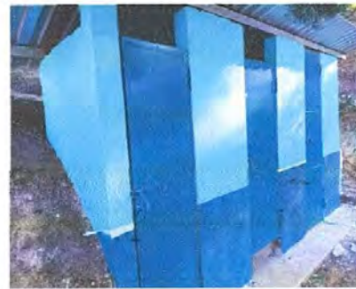
Foto 4: sustitución de puertas, repello y pintura de paredes inrior y exterior, sustitución de tazas de tazas de 2 baños
