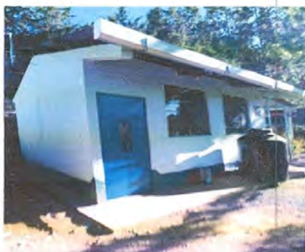
Foto 9: Reparacion de canales
