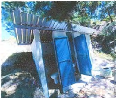
Foto 3: sustitucion de techa a baños
